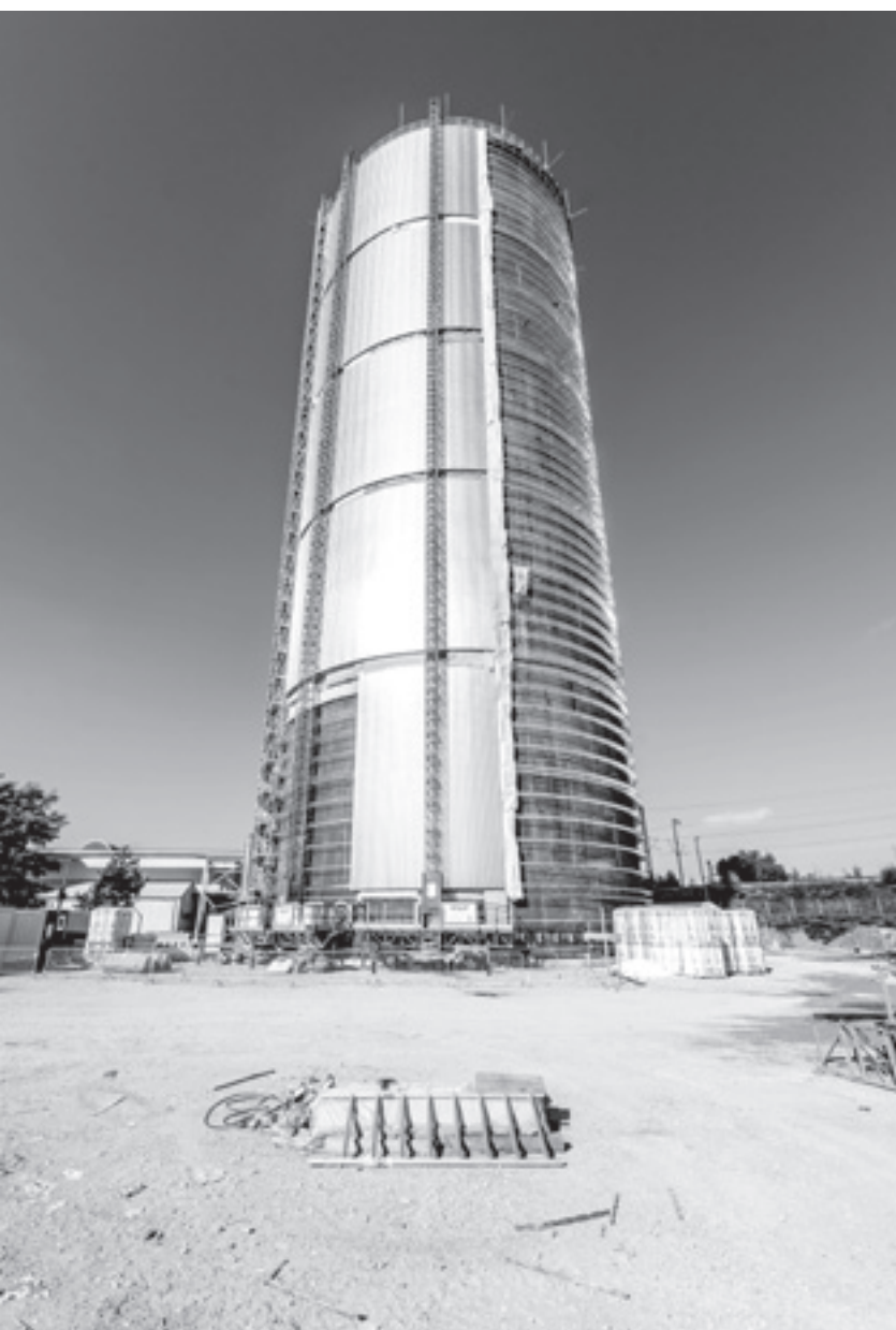
Vergleichbarer Speicher in Nürnberg mit einem Fassungsvermögen von 33.000 Kubikmetern, aufgenommen während der Bauphase.
