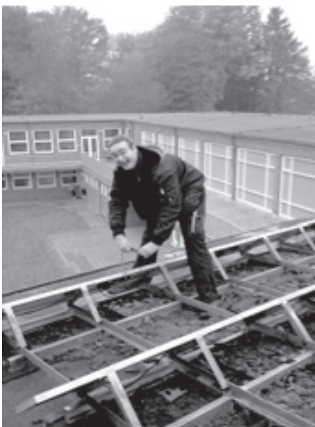
Azubi Mattis Blöhs bei Installationsarbeiten an der Photovoltaik-Anlage auf dem Dach der Friedrich-Junge-Schule.
