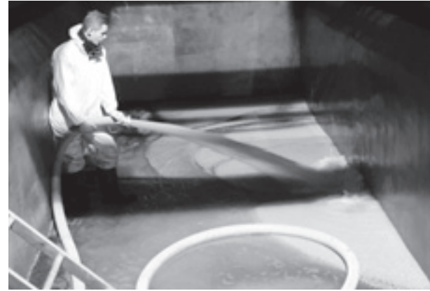
Ein Mitarbeiter spült den neuen Filterkies in das Filterbecken ein.
