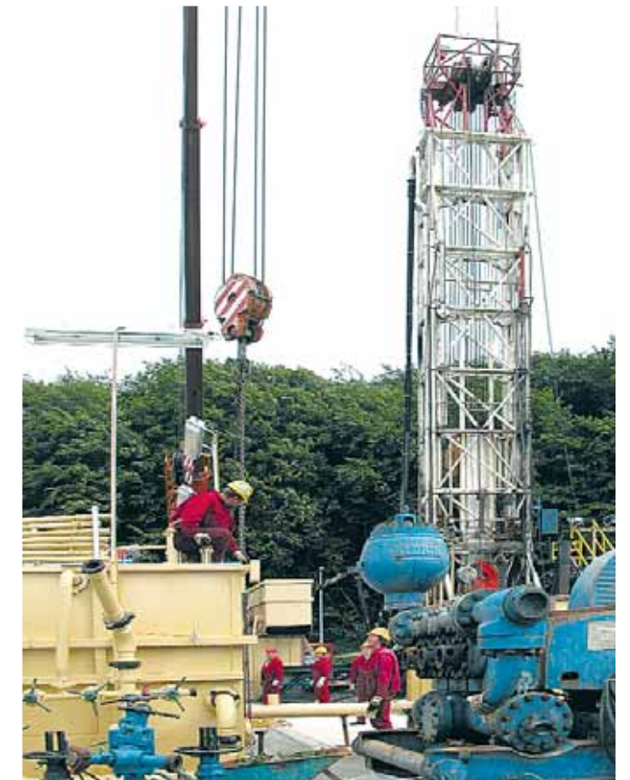
Von dem bereits installierten Bobrturm aus werden in Rönne in den kommenden Wochen zunächst sich nach unten verjüngende Rohrstücke bis auf eine Tiefe von 1.900 m abgesenkt.
