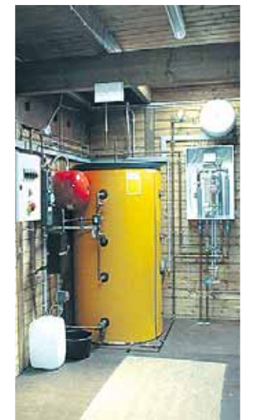
Manche mögen's heiß: Die Solarthermische Anlage erwärmt in diesem Kessel das Duschwasser für die Badegäste.
